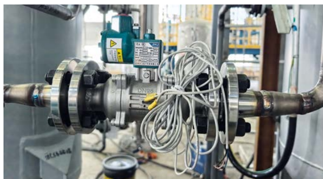
Рис. 5. Установка клапана JHJ на технологическом трубопроводе. По информации производителя, объект относится к производству адипонитрила
